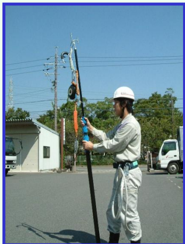
地上アクセス操作棒により、ベルブロックを任意の高さにセットします
