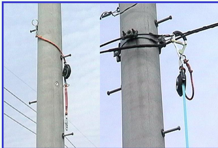
ベルブロックを電柱足場及び支持線にセットします
