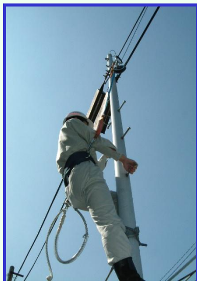
ベルブロック末端のフックを安全帯にセットし、安全に昇降が可能です
