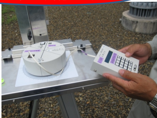
① 水準器でアンテナ取付用治具を水平に設置します 真北計に目的の方向を入力します
