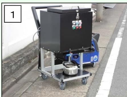
1 T. Cメルターと 発電機(100V/25A以上)を設置
