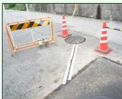
周辺舗装の亀裂補修
