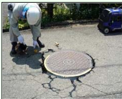
MH周辺舗装の亀裂補修
