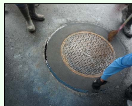
MH周辺舗装の縁端処理
