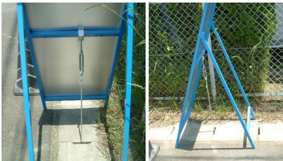
看板固定状況
